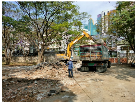
4-5 ชีดพรมน้ำเขตตักเศษวัสดุรื้อถอนใส่รถบรรทุกก่อนนำออกไปกำจัดที่ศูนย์กำจัดขยะอ่อนนุช
