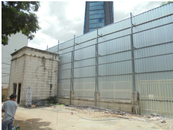
4-1 รั้วชั่วคราวสูง 6 เมตร กันขอบเขตพื้นที่โครงการบดบังช่วงรื้อถอนภายในโครงการ
