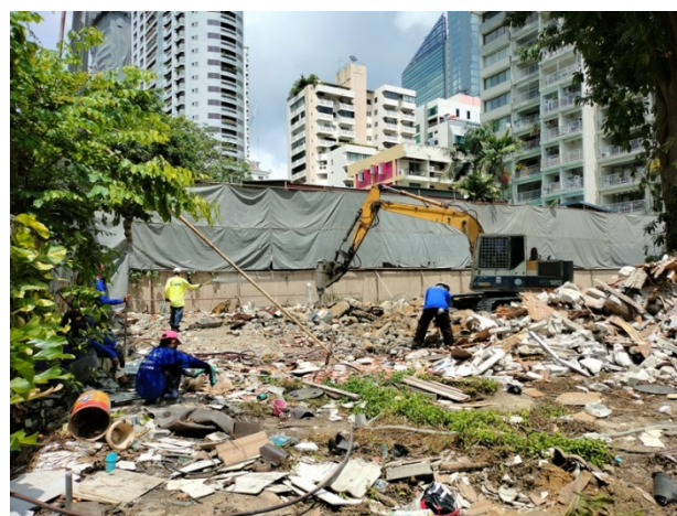
4-8 ขณะรื้อถอน การทำงานที่มีเสียงดัง ผู้ที่ฉีดน้ำและผู้ดำเนินการอยู่รอบเครื่องจักรให้อยู่ห่างในระยะ 4-8 เมตร
