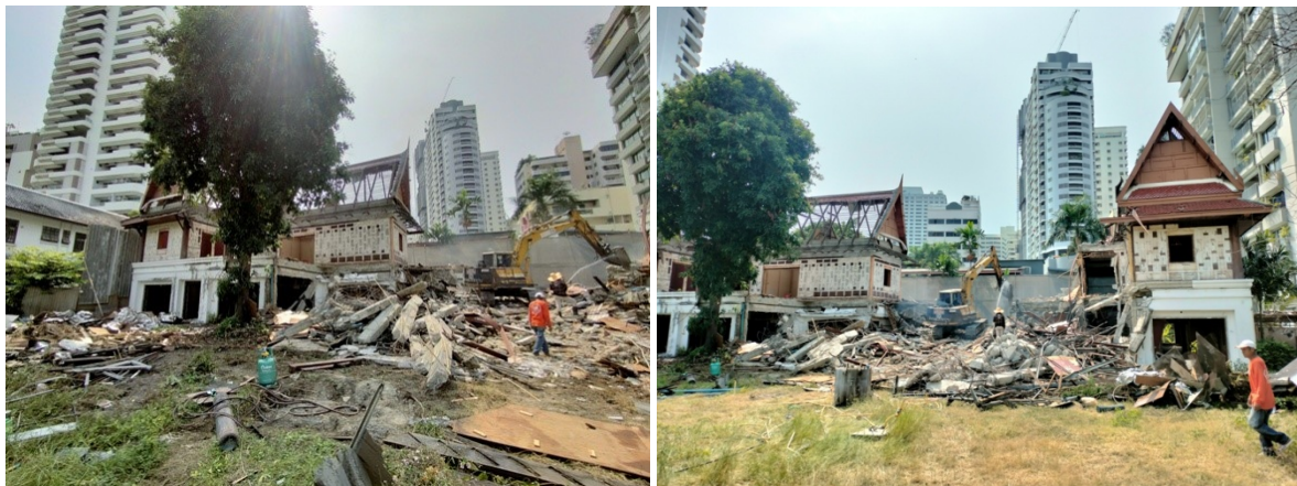
4-4 รื้อถอนอาคารสำนักงานเก่า ชีดพรมน้ำไม่ให้ฝุ่นละอองฟุ้งกระจาย
