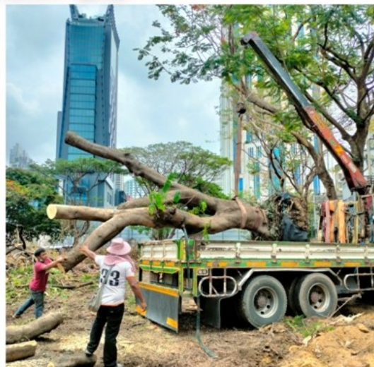
4-10 ล้อมต้นไม้ รัดกิ่ง รัดใบ ทำตุ้มดิน และใช้เครื่องจักรยกขึ้นใส่รถบรรทุกขนส่งออกจากโครงการ
