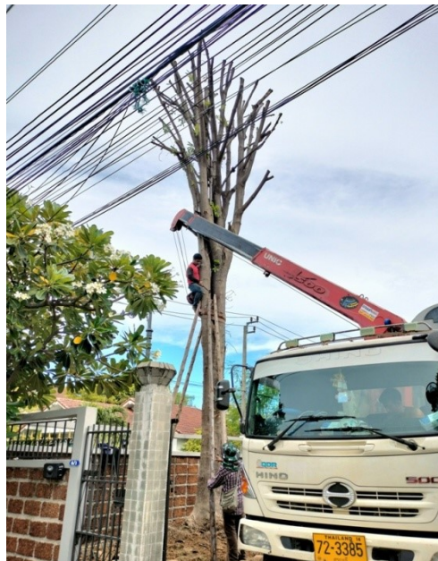
4-14 เครื่องจักรกลสำหรับยกต้นไม้ ใช้เครนจากรถขนส่ง และต้นไม้ที่อยู่ใกล้สายไฟและสายสื่อสาร ตัดและริดกิ่งออกก่อนขนย้าย
