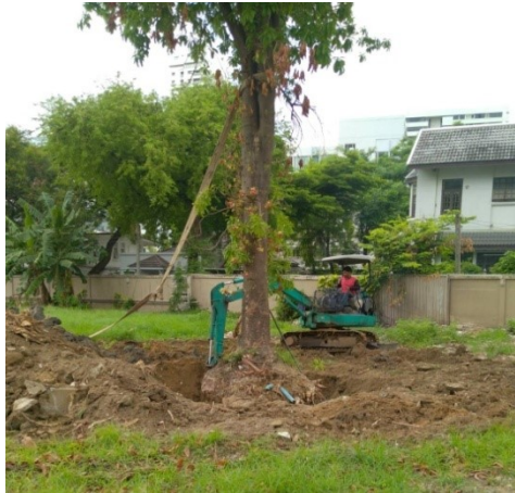
4-13 เครื่องจักรที่ใช้ในการขุด รื้อถอนต้นไม้ เป็นรถแบคโฮขนาดเล็ก
