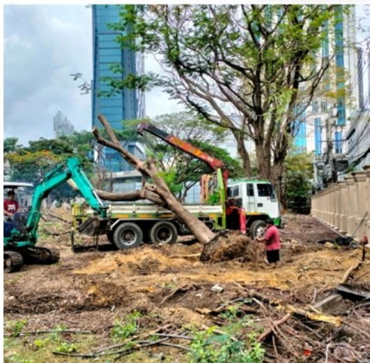
4-10 ล้อมต้นไม้ รัดกิ่ง รัดใบ ทำตุ้มดิน และใช้เครื่องจักรยกขึ้นใส่รถบรรทุกขนส่งออกจากโครงการ
