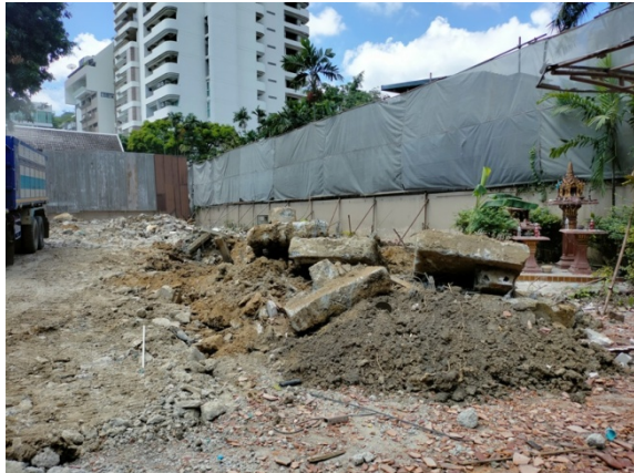
4-1 รั้วชั่วคราวสูง 6 เมตร กันขอบเขตพื้นที่โครงการบดบังช่วงรื้อถอนภายในโครงการ
